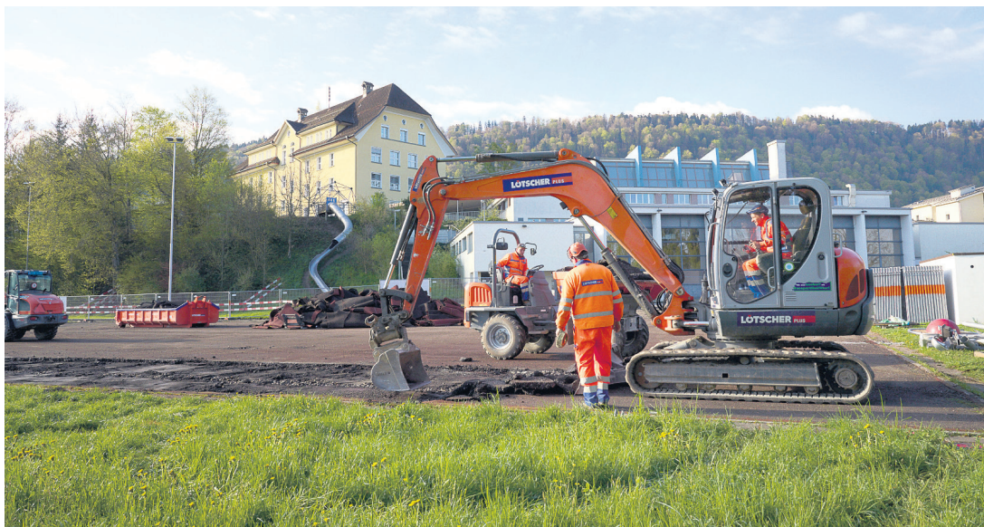
Der Baubeginn erfolgte termingerecht, der Sportplatz ist bereits Sperrzone, die Arbeiten gehen planmässig voran. Bis Frühling 2027 werden die Nutzerinnen und Nutzer der Schulanlage Littau Dorf mit verschiedenen Provisorien vorliebnehmen müssen.
